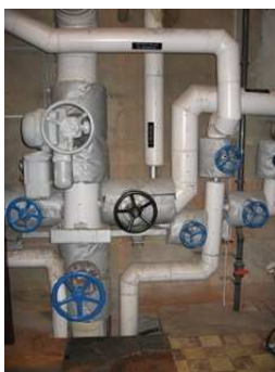
photo : « isol circuit froid_IMG_3675.jpg »
